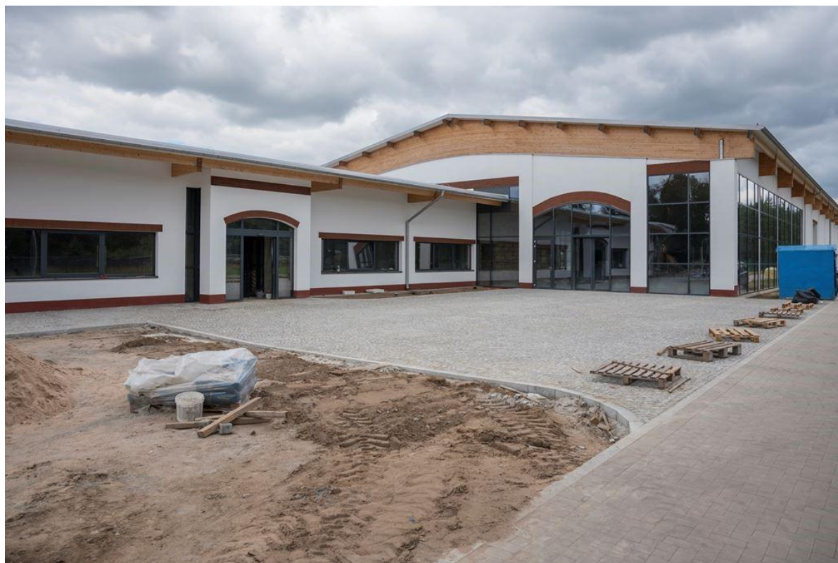
4 pav. Centrinės saugyklos komplekso statybų procesas
