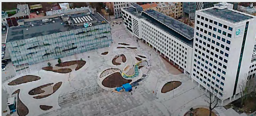
Vienybės aikštė Kaune (garažo stogo / aikštės dangų tvarkymo projektas)
