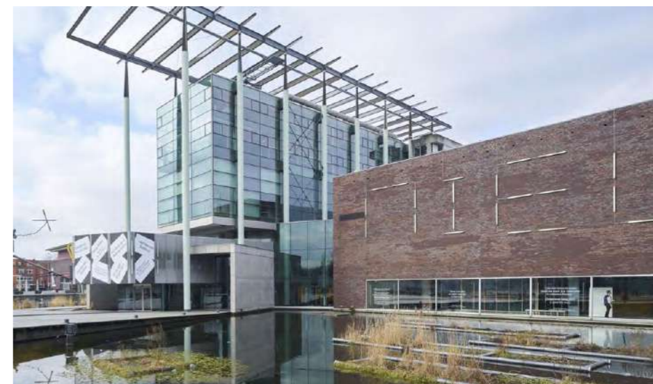
Pav. 74. Het Nieuwe Instituut, Nyderlandai (šaltinis: mvr.dv.nl)
