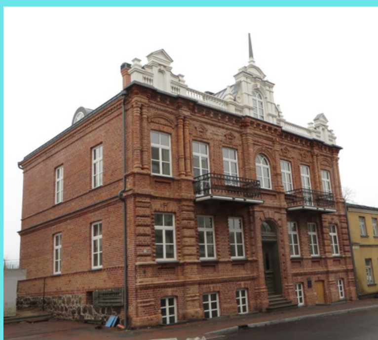
Pastatas Telšių r.
